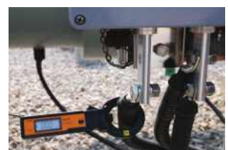
▲ 설치 후 전류 측정
