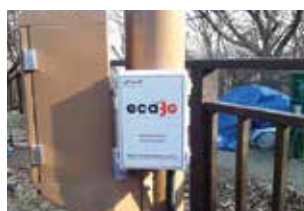
▲ 수방사 외곽경계 CCTV 함체
