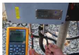
▲ 설치 후 전압 측정
