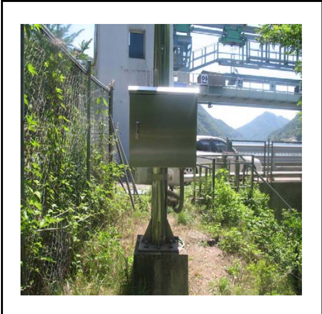
공사설명 6. 공도교 끝 출입구 감시 카메라 합체설치
