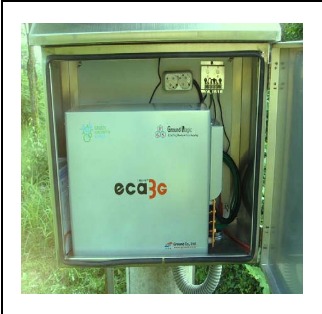
공사설명 | 13. 방류예경보 제2국 장비설치
