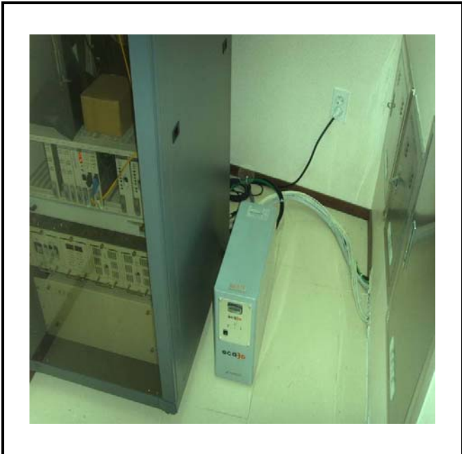
공사설명 17.공용사택 경비실 장비설치
