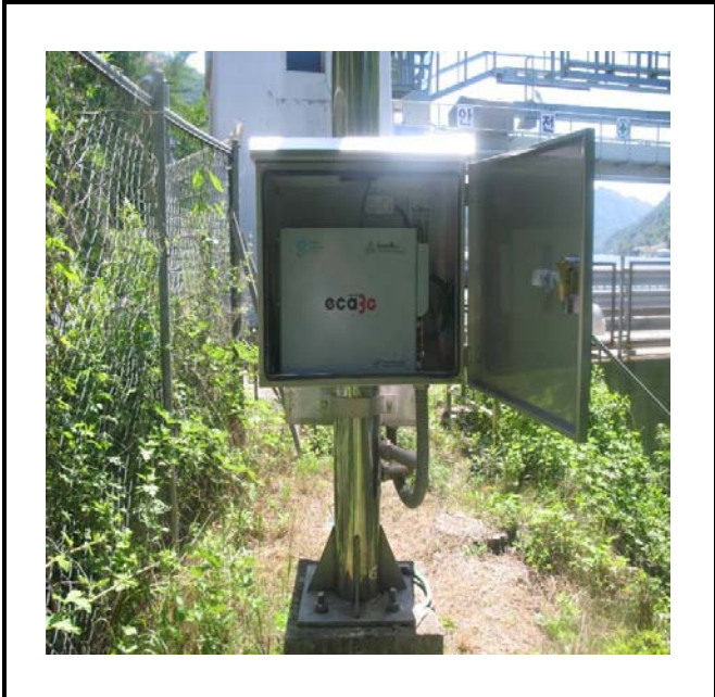
공사설명 6. 공도교 끝 출입구 감시 카메라 장비설치
