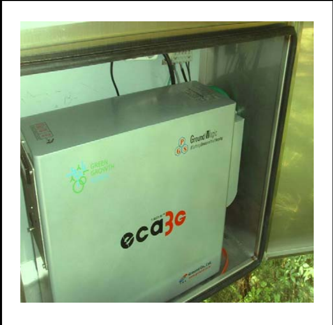
공사설명 12. 방류예경보 제1국 장비설치
