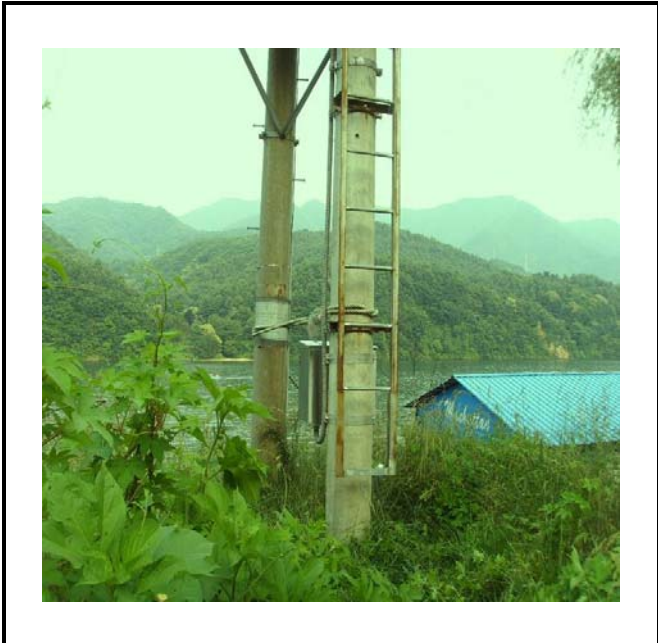
공사설명 | 14. 방류예경보 제3국 합체설치
