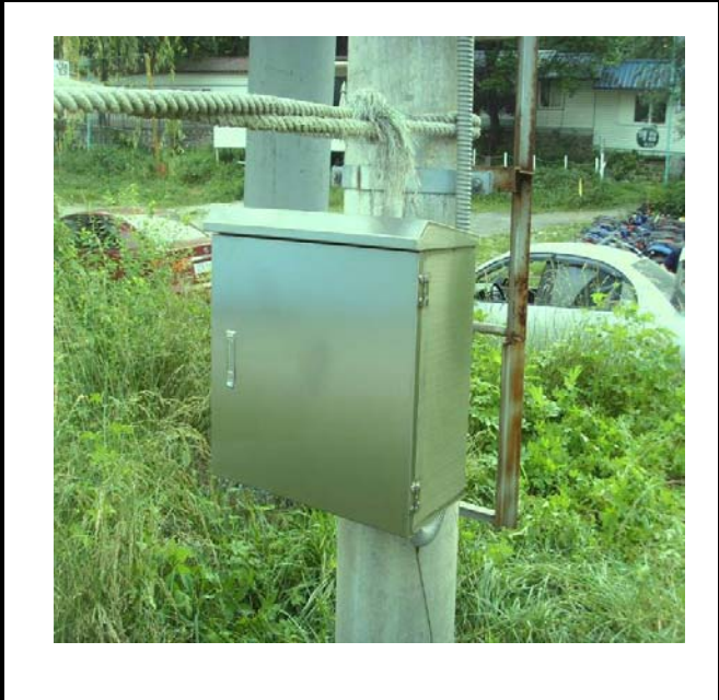
공사설명 14. 방류예경보 제3국 함체설치
