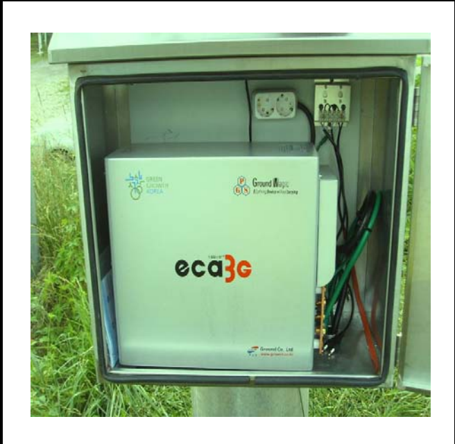
공사설명 14. 방류예경보 제3국 장비설치
