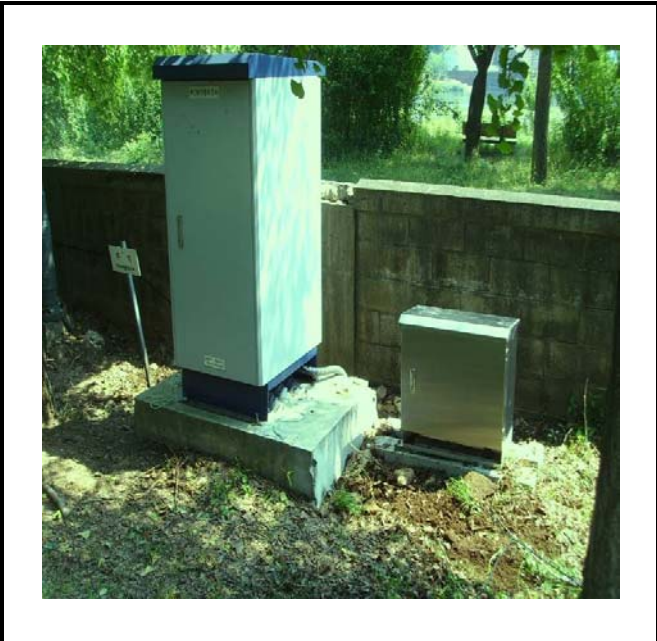
공사설명 16. 사택 앞 옥외통신함체 함체설치
