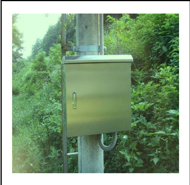
공사설명 | 13. 방류예경보 제2국 합체설치
