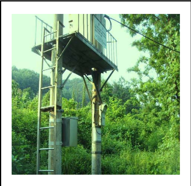
공사설명 13. 방류예경보 제2국 합체설치
