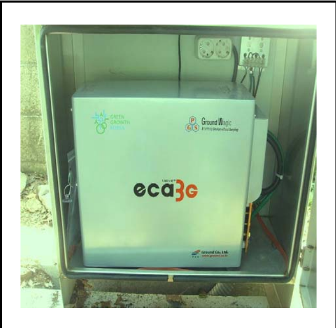
공사설명 16. 사택 앞 옥외통신함체 장비설치
