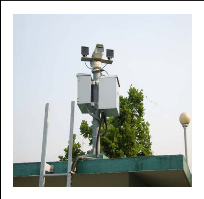
공사설명 13. 강릉발전소입구망루감시카메라 합체설치
