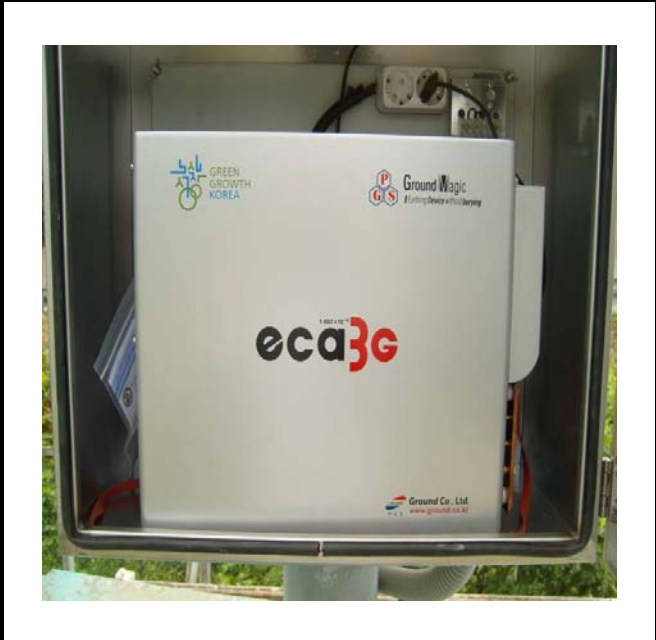
공사설명 13. 강릉발전소입구망루감시카메라 장비설치
