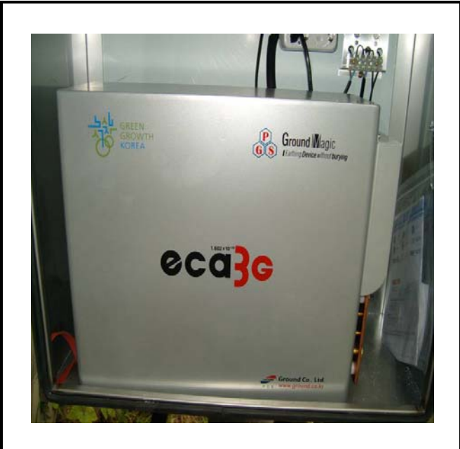
공사설명 | 8. 강릉발전소울타리감시카메라 장비설치
