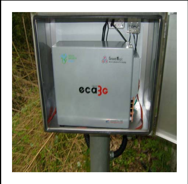
공사설명 | 7. 강릉발전소울타리감시카메라 장비설치
