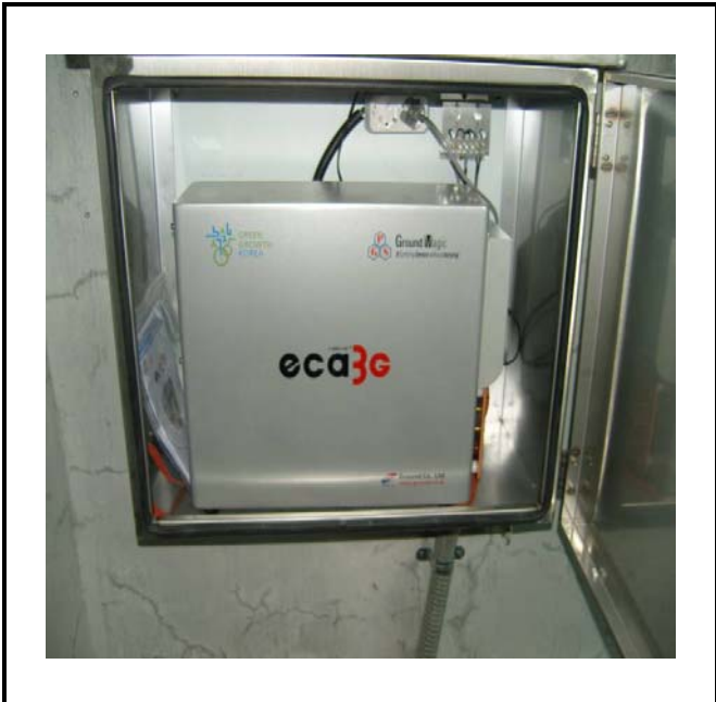
공사설명 15. 방류예경보 제1국 장비설치
