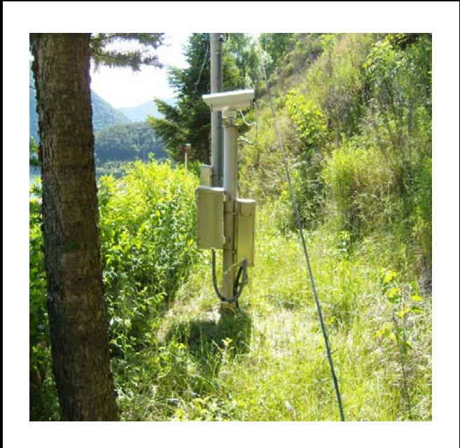
공사설명 1. 도암댐초소 앞 감시 카메라 함체설치
