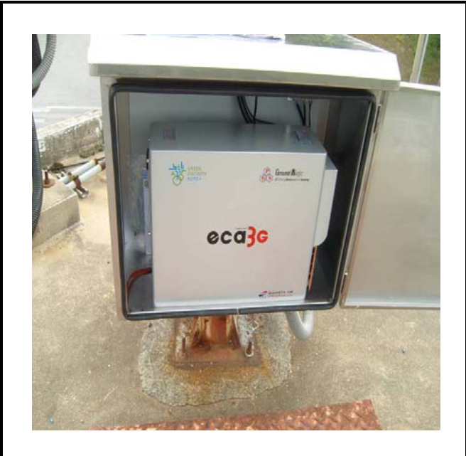
공사설명 | 10. 강릉발전소중간망루감시카메라1 장비설치
