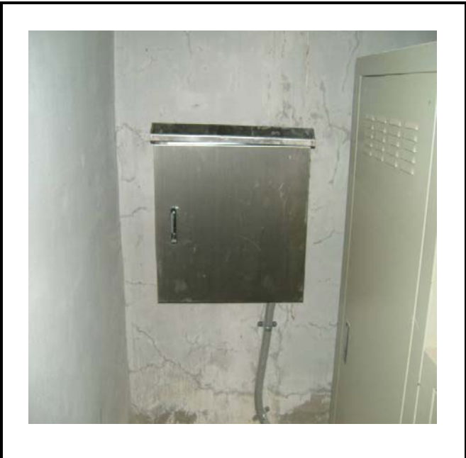
공사설명 15. 방류예경보 제1국 함체설치
