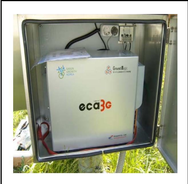
공사설명 5. 도암댐 팔각정 옆 감시 카메라 장비 설치
