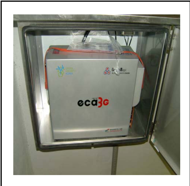
공사설명 16. 방류예경보 제2국 장비설치
