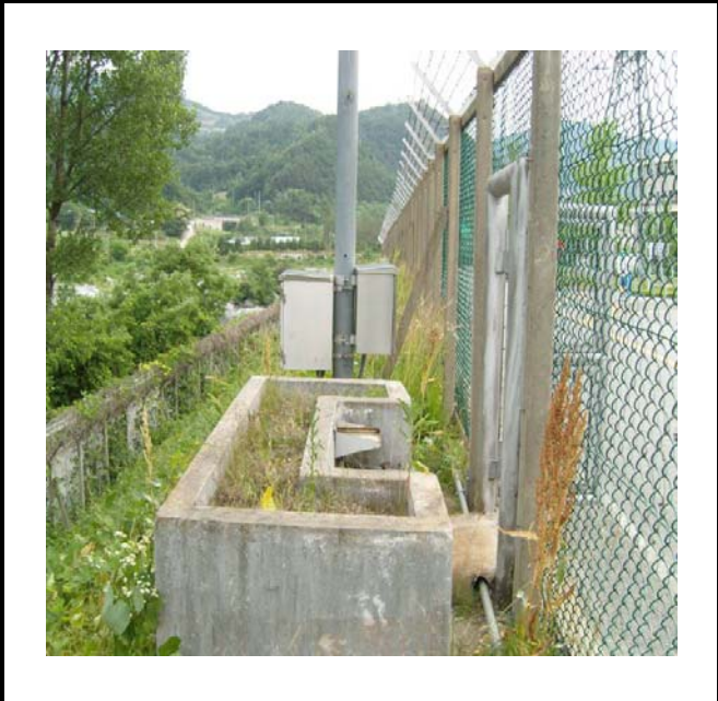
공사설명 | 12. 강릉발전소입구감시카메라 합체설치
