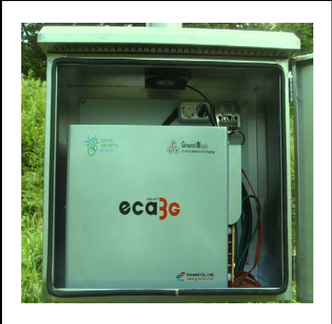
공사설명 | 9. 강릉발전소울타리감시카메라 장비설치
