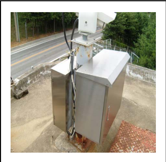
공사설명 | 10. 강릉발전소중간망루감시카메라1 합체설치
