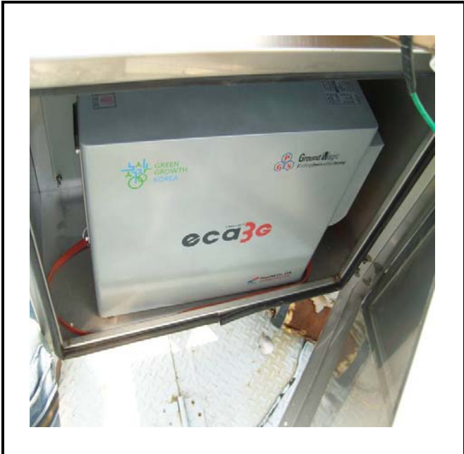
공사설명 6. 강릉발전소 울타리 감시 카메라 장비 설치
