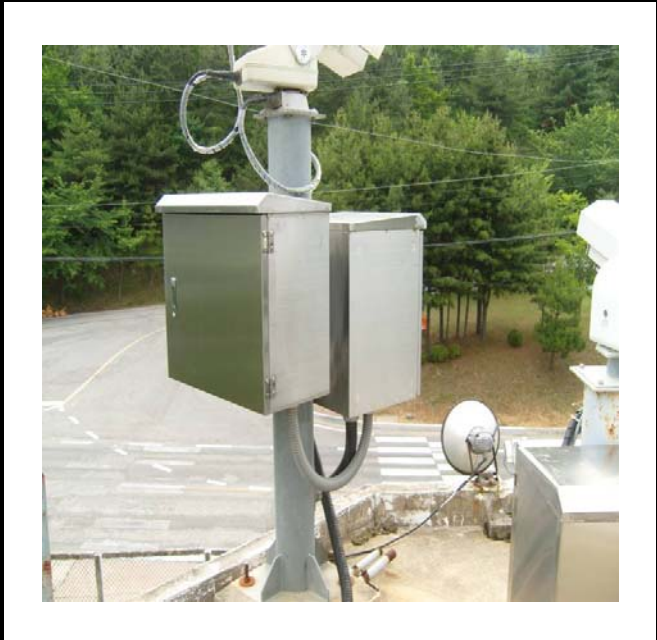
공사설명 | 11. 강릉발전소중간망루감시카메라2 합체설치
