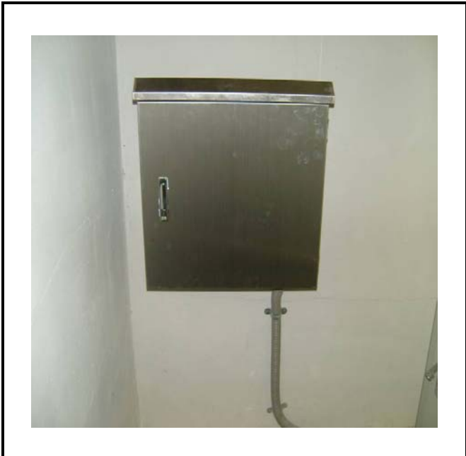
공사설명 16. 방류예경보 제2국 함체설치
