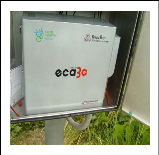
공사설명 | 12. 강릉발전소입구감시카메라 장비설치
