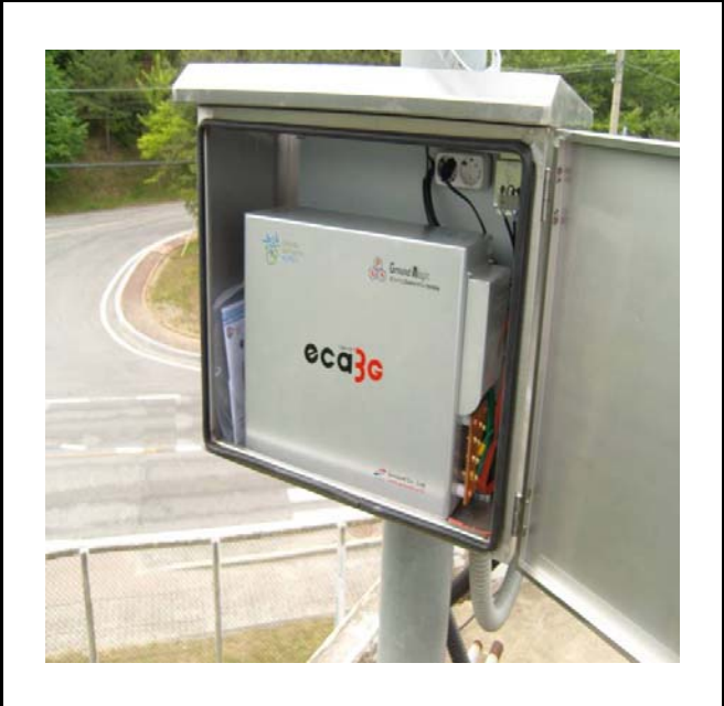
공사설명 | 11. 강릉발전소중간망루감시카메라2 장비설치
