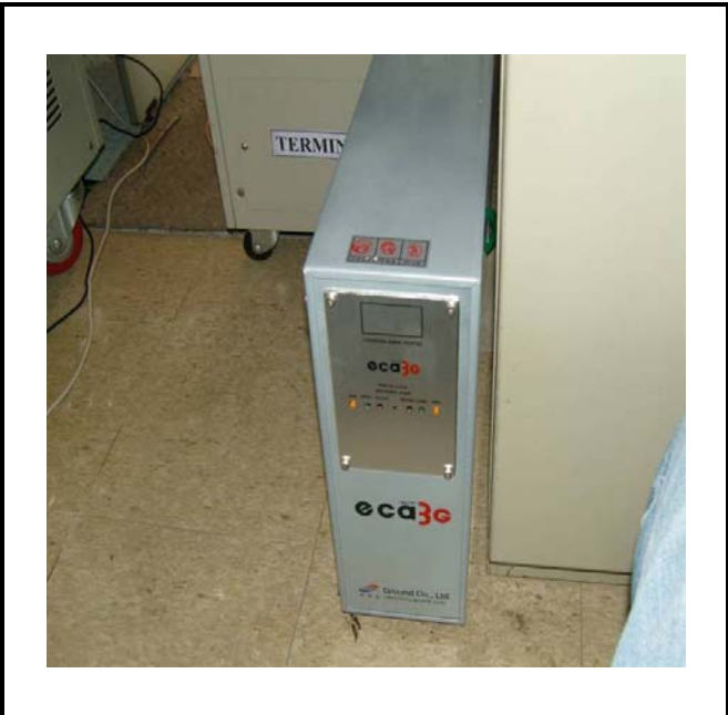
공사설명 20. 댐 제어실 장비설치
