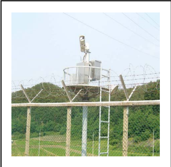
공사설명 6. 강릉발전소 울타리 감시 카메라 함체 설치
