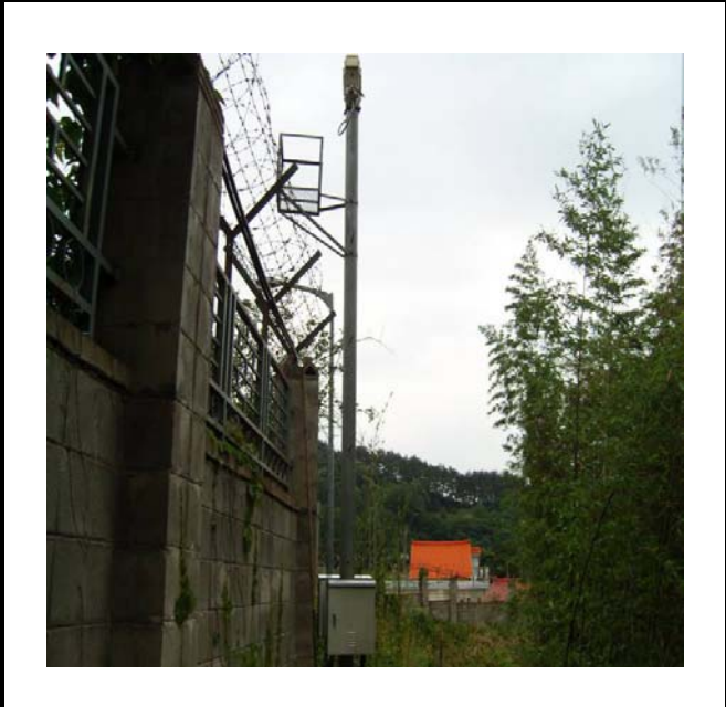
공사설명 | 7. 강릉발전소울타리감시카메라 합체설치
