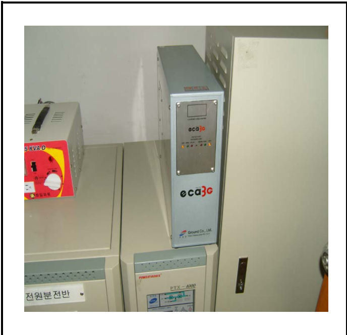
공사설명 23.댐 제어실 장비설치
