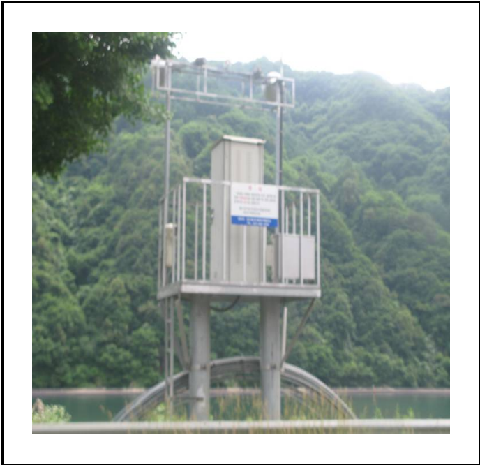
공사설명 19. 방류예경보 제3국 합체설치
