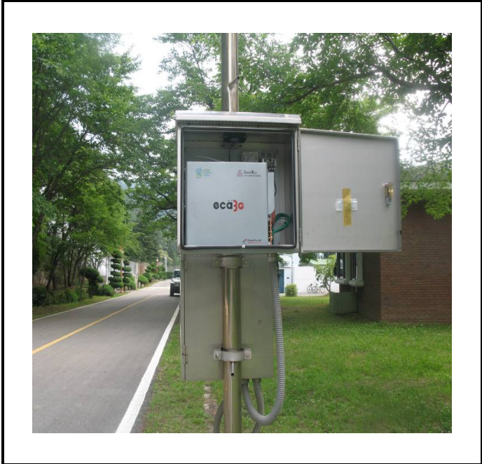
공사설명 4. 후문출입구 감시 카메라 설치완료
