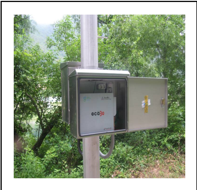
공사설명 6. 후문 적외선 감시 카메라 1 접지장치설치
