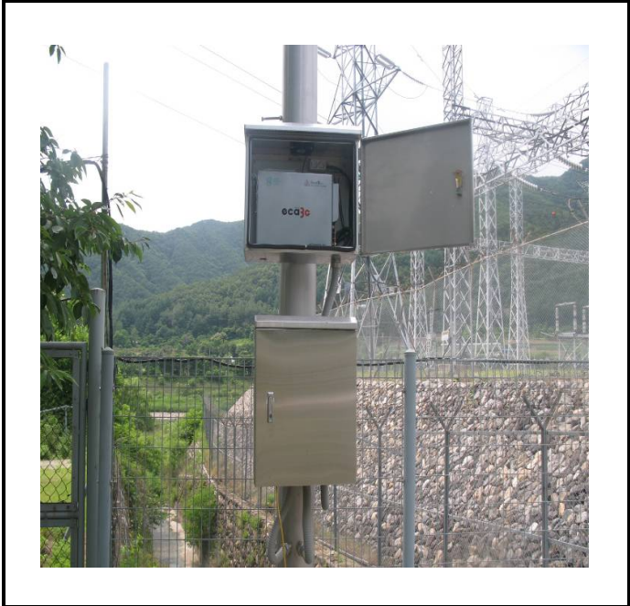
공사설명 5. 사무실 뒤 감시 카메라 접지장치 설치
