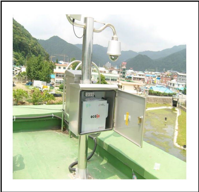
공사설명 21. 화천 펌프장 옥상 감시 카메라 장비설치
