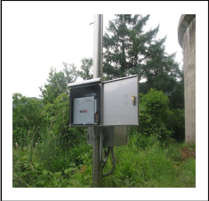
공사설명 2. 외곽 울타리 감시 카메라 설치완료
