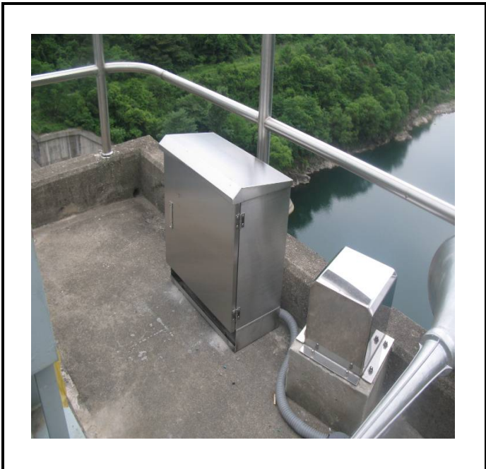
공사설명 8. 댐하류 영상카메라 합체설치
