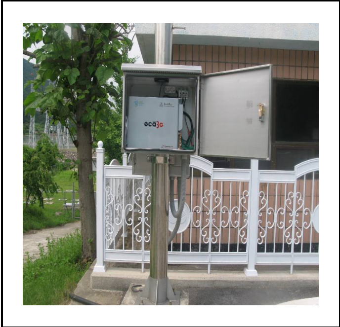
공사설명 1. 정문 입구 감시 카메라 설치완료
