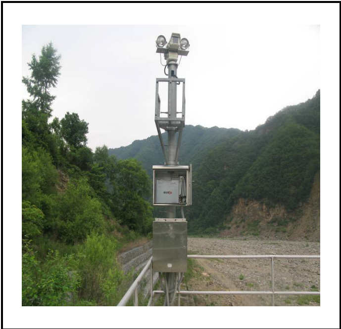
공사설명 9. 댐 전경 감시 카메라접지장치 설치
