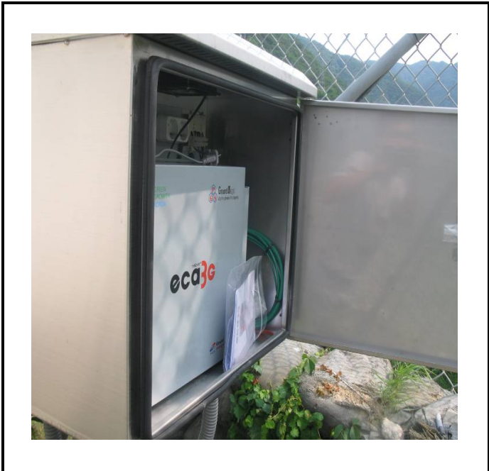
공사설명 | 11. 옥외 S/S 제2초소 감시 카메라 접지장치 설치
