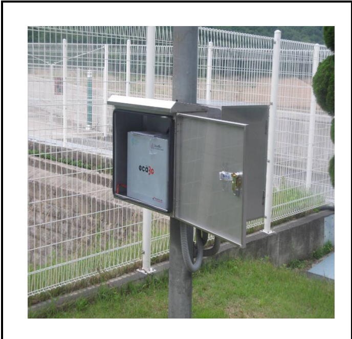
공사설명 | 10. 댐 공도교 감시 카메라 접지장치 설치
