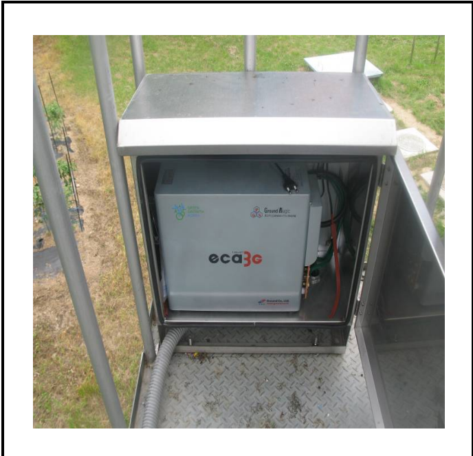
공사설명 17. 방류예경보 제1국 장비설치
