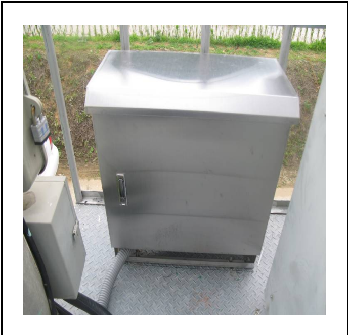
공사설명 18. 방류예경보 제2국 합체설치
