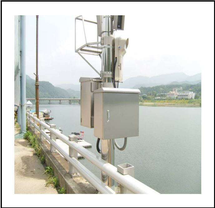
공사설명 20. 화천펌프장 배수구 감시 카메라 합체설치
