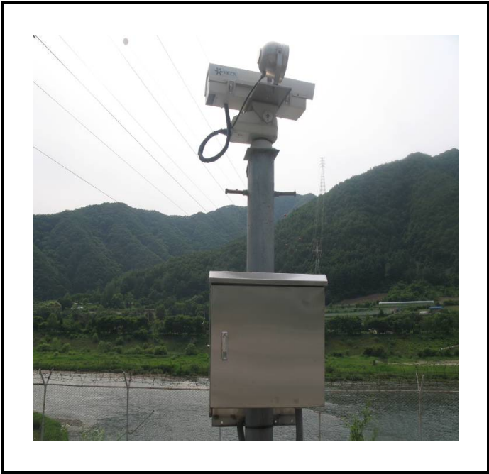
공사설명 12. 옥외 S/S 제3초소 감시카메라 합체설치
