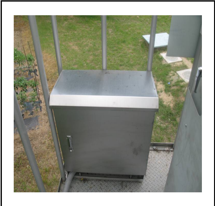
공사설명 17. 방류예경보 제1국 합체설치
