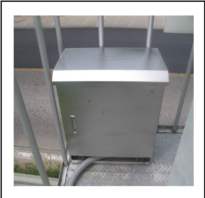
공사설명 19. 방류예경보 제3국 합체설치
