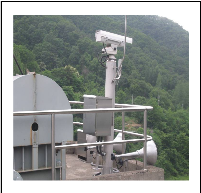
공사설명 8. 댐하류 영상카메라 합체설치
