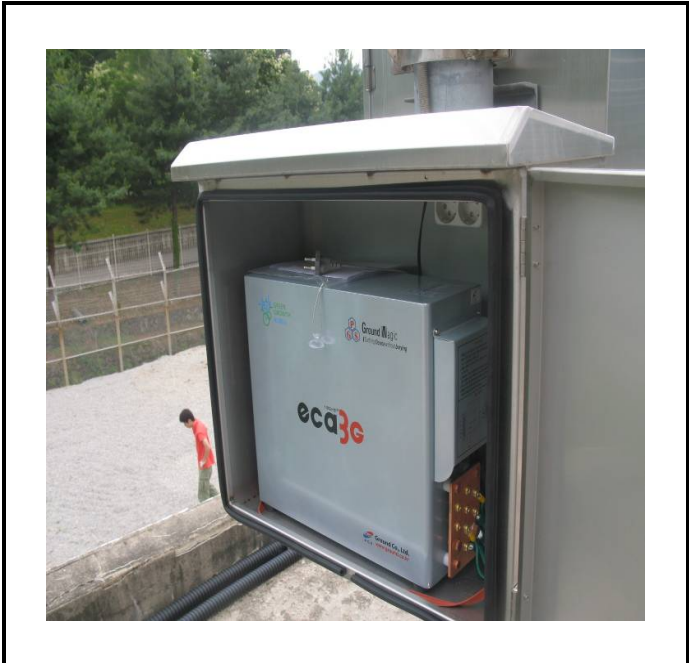
공사설명 15. 창고위 무기고 감시 카메라 접지장치 설치
