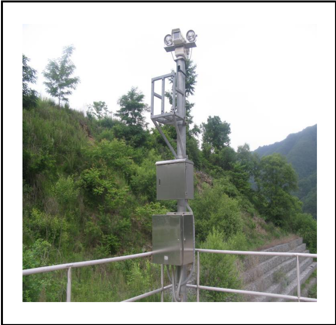
공사설명 9. 댐 전경 감시 카메라 합체설치
