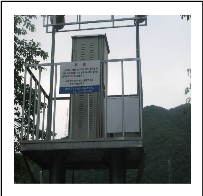
공사설명 17. 방류예경보 제1국 합체설치
