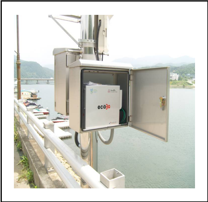
공사설명 20. 화천펌프장 배수구 감시 카메라 장비설치
