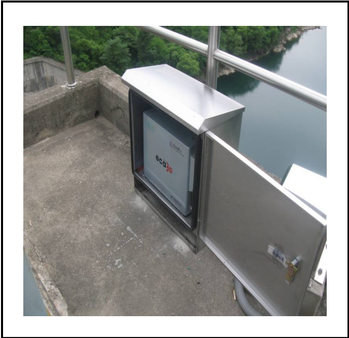
공사설명 8. 댐하류 영상카메라접지장치 설치
