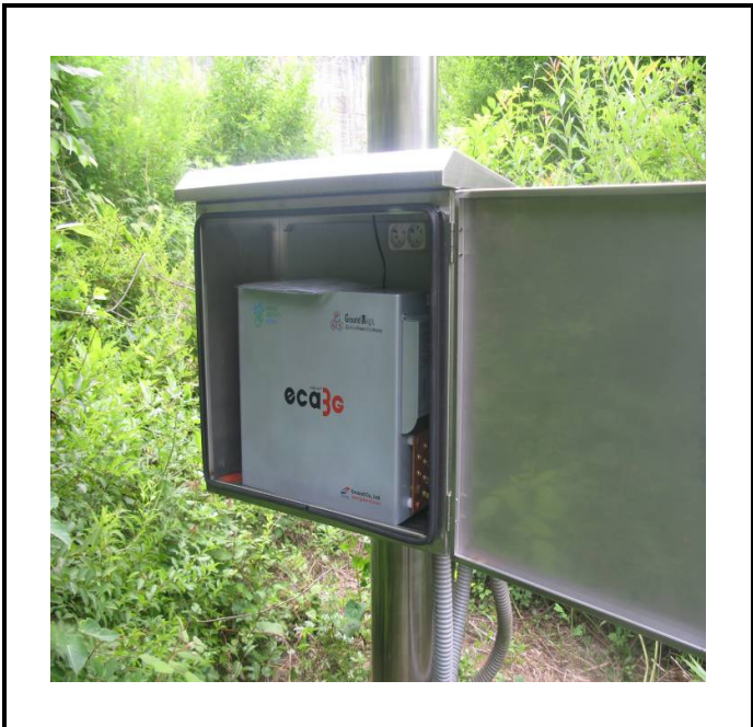
공사설명 3. 써지탱크 감시 카메라 접지장치 설치
