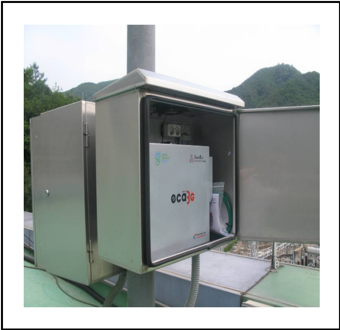
공사설명 13. 발전소 옥상 방류구 감시 카메라 정지장치 설치
