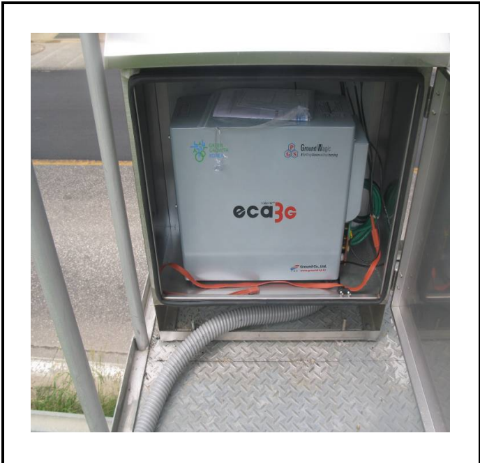
공사설명 19. 방류예경보 제3국 장비설치
