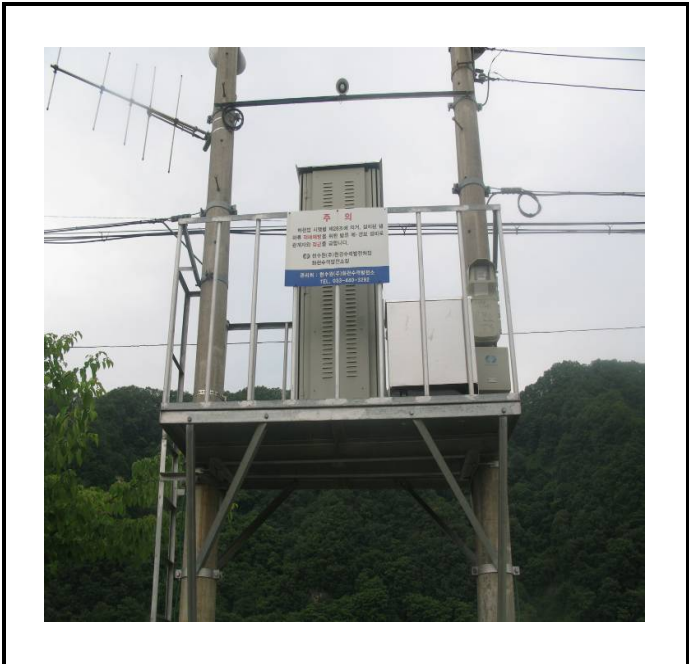
공사설명 18. 방류예경보 제2국 합체설치
