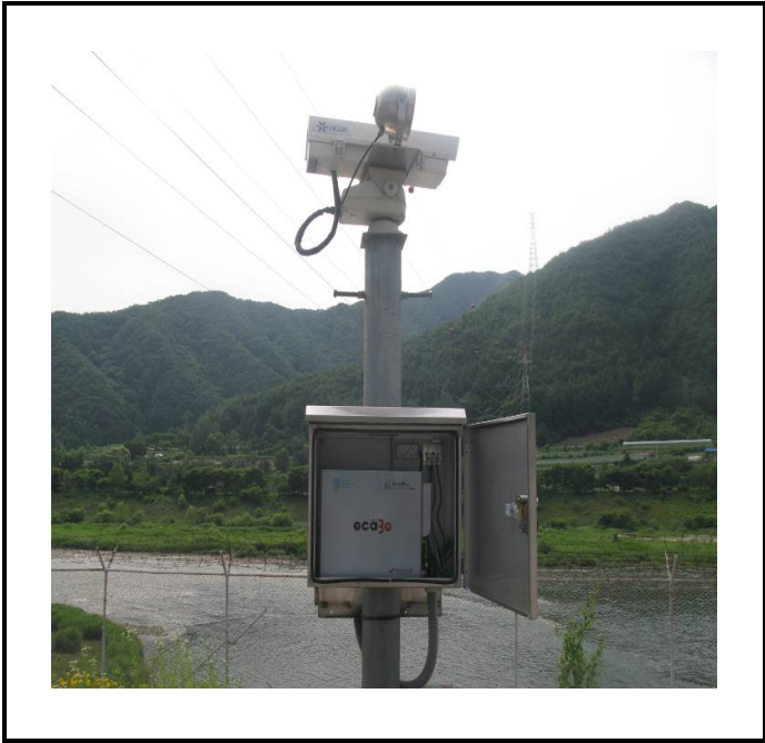
공사설명 12. 옥외 S/S 제3초소 감시카메라 접지장치 설치
