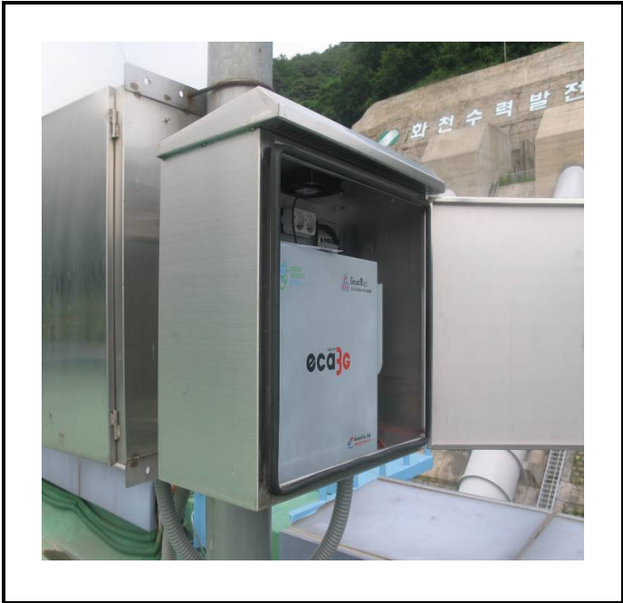
공사설명 14. 발전소 옥상 S/S 감시 카메라 접지장치 설치
