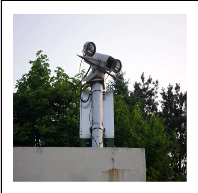
공사설명 1. 발전소 경비실 입구 카메라 설치 전
