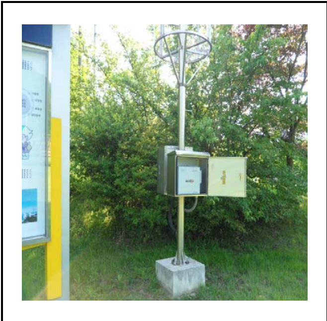
공사설명 7. 입구 주차장감시카메라 장비설치
