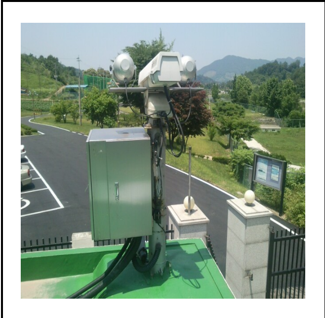
공사설명 1. 발전소 경비실 입구 카메라 설치 전
