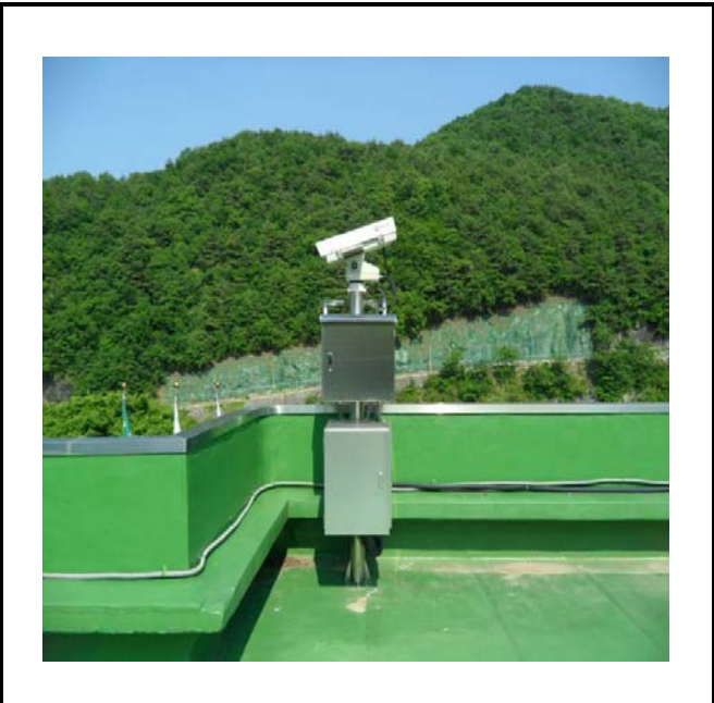
공사설명 2. 사옥 옥상 출입구 감시 카메라 합체설치
