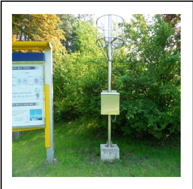
공사설명 7. 입구 주차장감시카메라 합체설치
