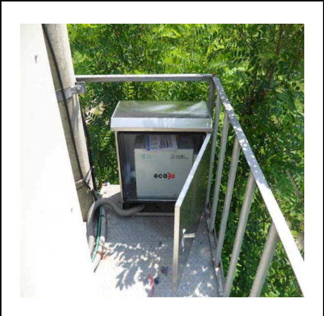
공사설명 10. 방류예경보 제3국 장비설치
