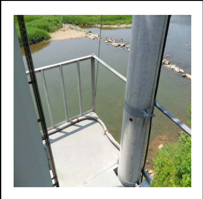
공사설명 9. 방류예경보 제 2국 설치 전
