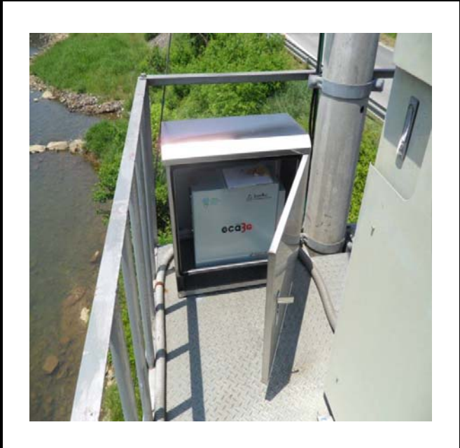
공사설명 9. 방류예경보 제 2국 장비설치
