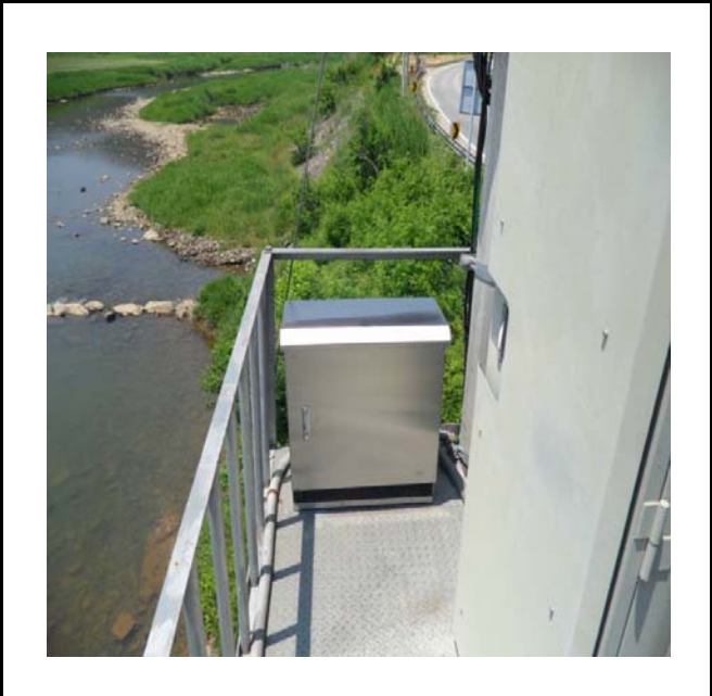
공사설명 9. 방류예경보 제 2국 합체설치
