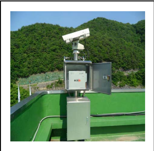
공사설명 2. 사옥 옥상 출입구 감시 카메라 장비설치
